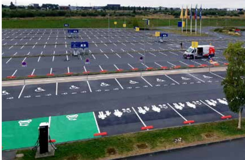
Service & Travaux Marquage au sol Parking Ikea / Caen
