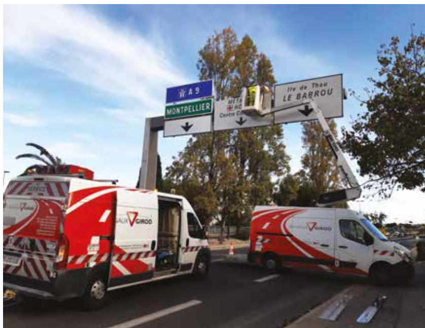
Service & Travaux Pose panneau directionnel / A9
