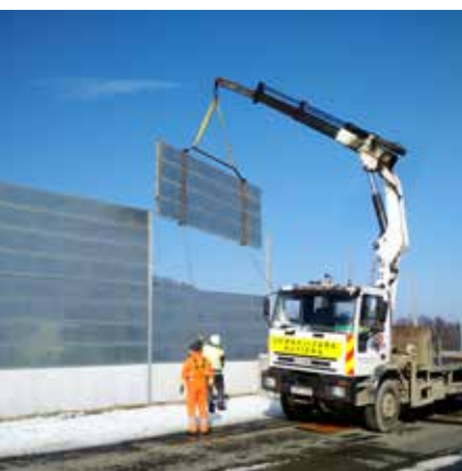
Services & Travaux Panneaux anti-bruit Roumanie
