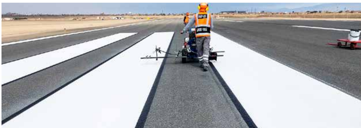
Services & Travaux Marquage aéroport Lima Pérou
