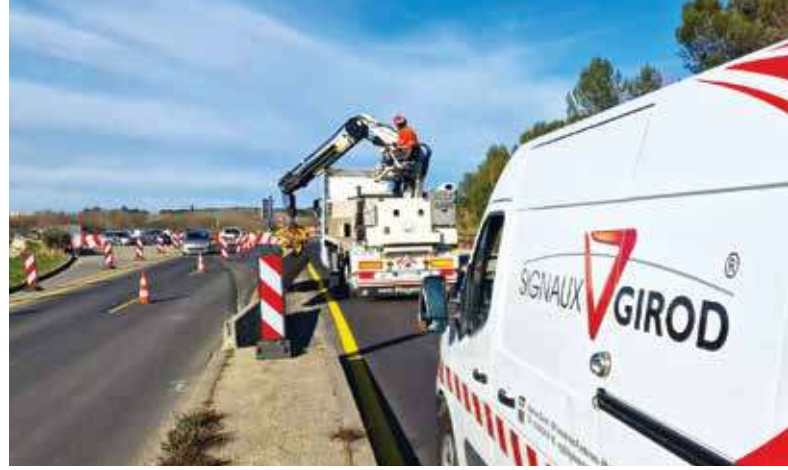
Service & Travaux Location et pose de balisage
